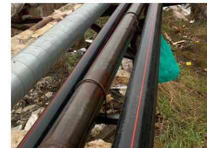
После замены сетей ГВС на РЕ-RT пластик повышенной термостойкости
