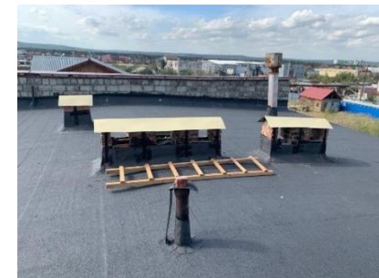
После замены кровли кот. "Покровский тракт 4 км."
