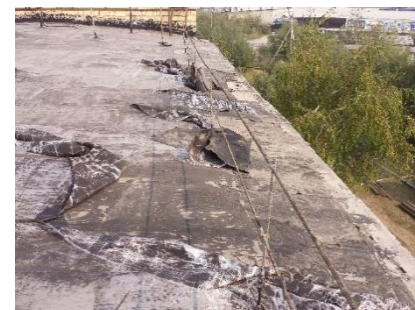
До ремонта кровли кот. "Покровский тракт 4 км."
