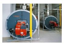
Произвести техническое перевооружение котельной «Школа» в с.Хатассы. Установка 3-х новых котлов Viessmann Vitomax lw тип m22
