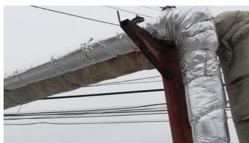
После замены сетей ГВС на PPR, PE-RT пластик повышенной термостойкости
