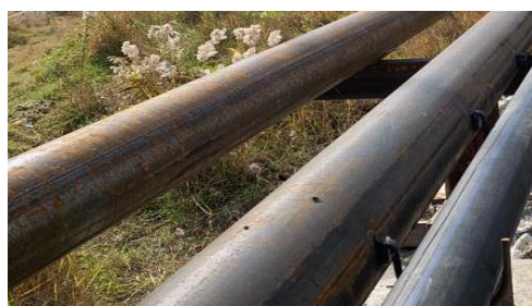
После замены сетей ТН, ХВС на ПЭ
