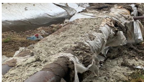
До ремонта сетей ТН, ХВС от кот. «4 квартал»
