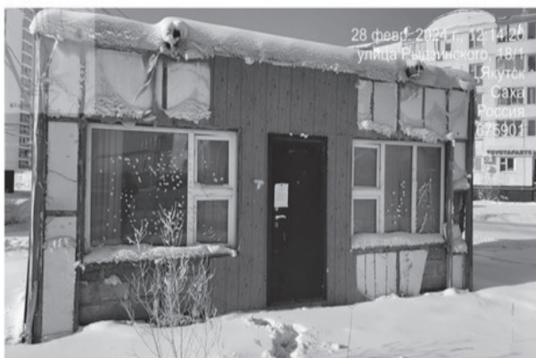
Фото 1: Вид на павильон расположенный по адресу: г. Якутск ул. Рызинского д. 18/1
