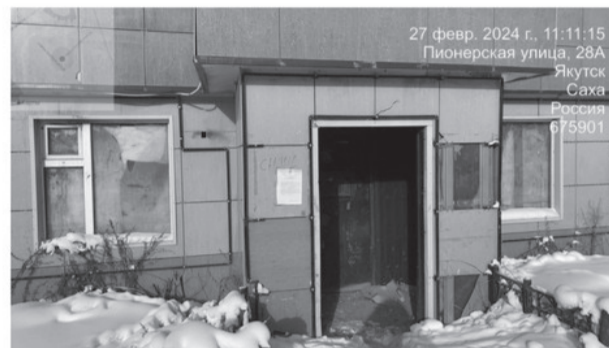
Фото 2: Вид на павильон расположенный по адресу: г. Якутск ул. Пионерская д. 28А
