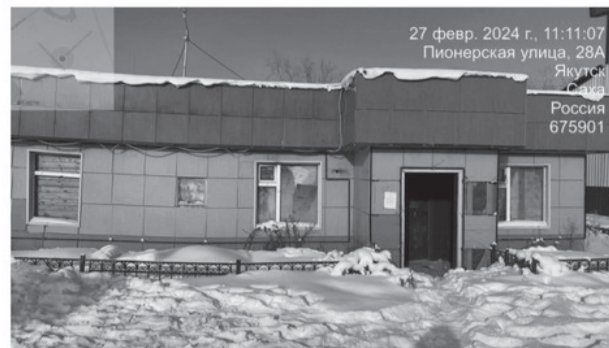
Фото 1: Вид на павильон расположенный по адресу: г. Якутск ул. Пионерская д. 28А
