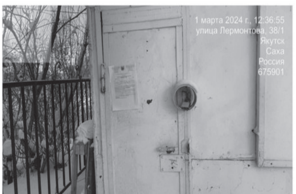
Фото 3: Вид на павильоны расположенных по адресу: г. Якутск ул. Лермонтова д. 38/1
