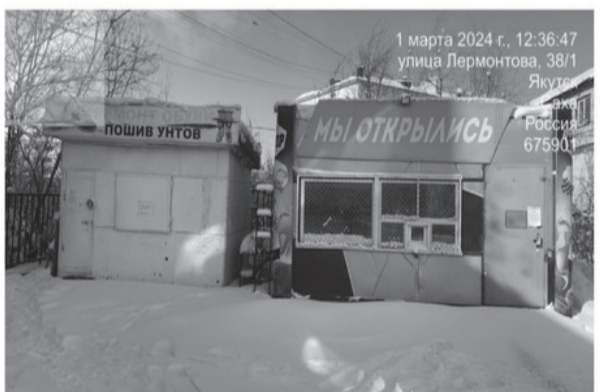
Фото 1: Вид на павильоны расположенных по адресу: г. Якутск ул. Лермонтова д. 38/1
