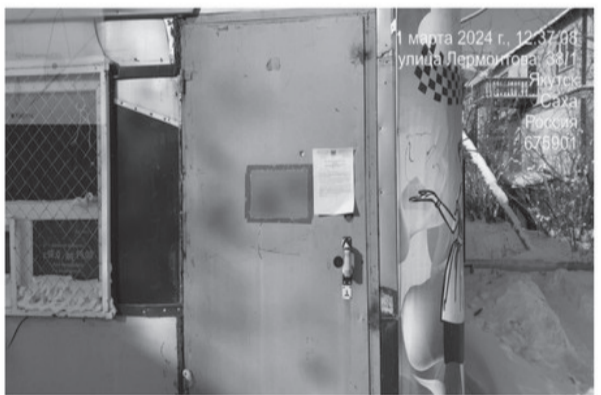
Фото 2: Вид на павильоны расположенных по адресу: г. Якутск ул. Лермонтова д. 38/1
